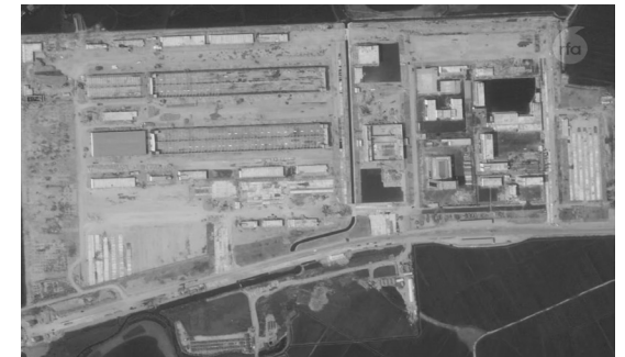
〈미국의 상업위성이 7월 20일에 촬영한 신압록강대교의 북한 측 세관 공사 현장 (사진=RFA)〉
