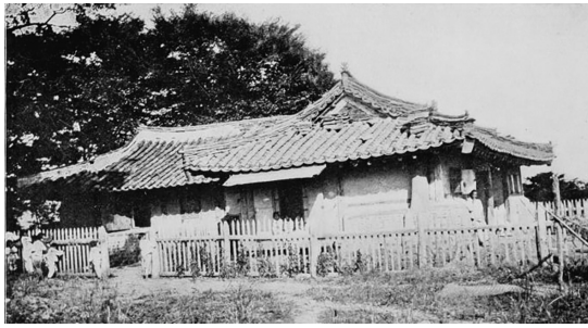
〈1883년 황해도 장연군 대구면 송천리 소재마을에 세워진, 한국 최초의 개신교 교회인 소래 교회〉
